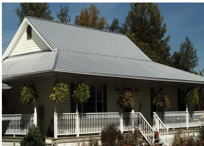
Côte Rigole (toit pente faible) (vis apparentes)
