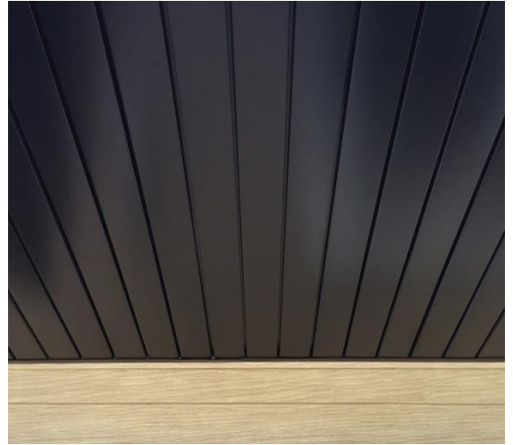
Soffite à ventilation cachée (Truvent)
